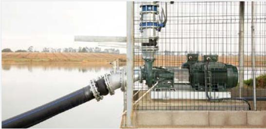
La tête peut être **alimentée** par 12Vdc (avec panneau solaire et batterie, ou seulement batterie) ou 220Vac (secteur ou groupe électrogène).
