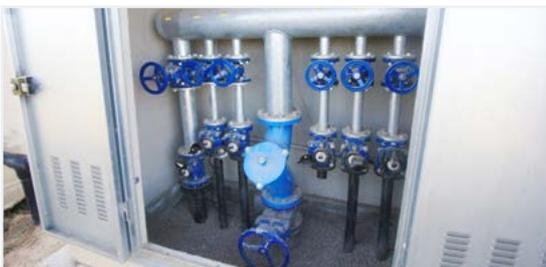
Dans la tête, il peut y avoir une **fertilisation** avec un injecteur à moteur hydraulique, des doseurs électriques ou un système de venturis.
