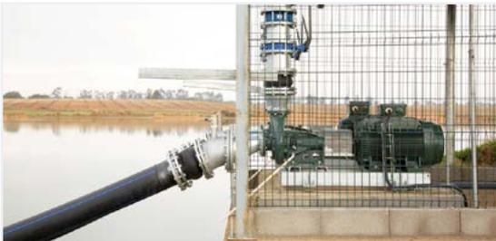
**Setor:** corresponde a uma válvula de rega que abre a água a uma parte da quinta, por exemplo, um ramal de goteiras. A cada setor pode ser atribuído um motor para que quando se ativar o setor também se ative o motor.
