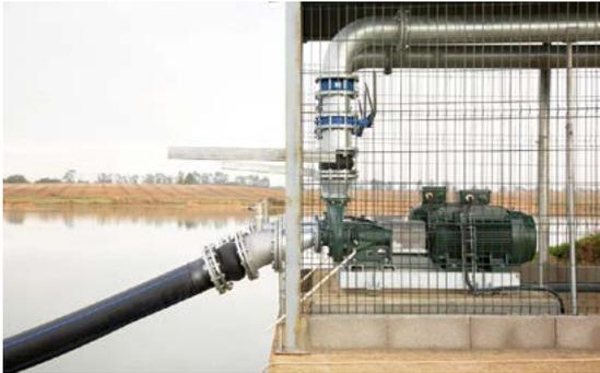
O cabeçal pode ter **alimentação** a 12Vdc (com painel solar e bateria, ou só bateria) ou a 220 Vac (rede ou grupo gerador).
