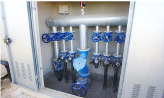
En el cabezal puede haber **fertilización** con inyector de motor hidráulico, dosificadoras eléctricas o sistema de venturis.
